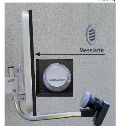
Drehen Sie nun den Offsetspiegel langsam von Osten nach Westen (wenn Sie hinter der Antenne stehen, von links nach rechts), bis Sie ein Bild des Satelliten auf Ihrem Fernseher erhalten.
